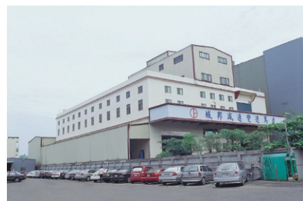
台灣廠房 TAIWAN FACTORY
