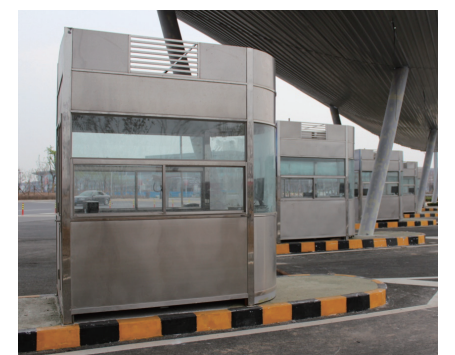
咸阳机场-T3航站楼
